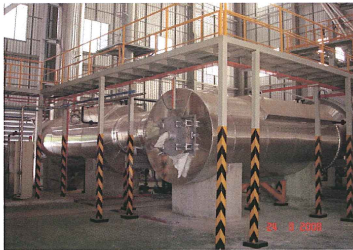
After Burner 1 & 2 ที่ใช้เชื้อเพลิงจาก Green Gas
