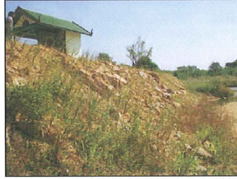
รูปที่ 2.1 การปลูกหญ้าหรือพืชคลุมดินตามพื้นที่ที่มีความลาดชัน
