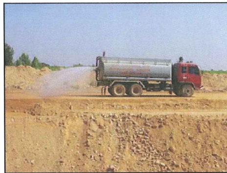
รูปที่ 2.2 การฉีดพรมน้ำบริเวณพื้นที่ก่อสร้างที่ทำการเปิดหน้าดิน
