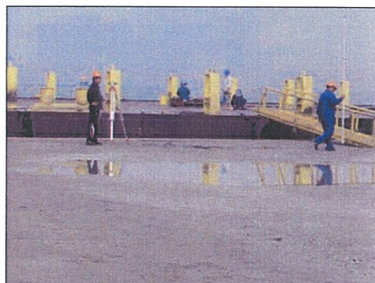
รูปที่ 3.1-3 ถ่ายค่าระดับจากหมุด CU-40 ไปยัง Digital Tide Gauge
