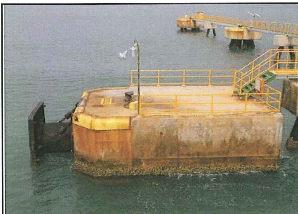
หลักเทียบเรือ ยางกันกระแทกและหลักผูกเรือ
