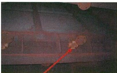
Blind flang ที่ต้องปิดก่อนเติม PT (ไม่ต้องใส่ gesket )
