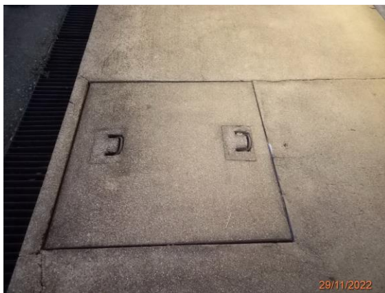
บ่อดักน้ำติดตั้งอยู่เป็นระยะ
