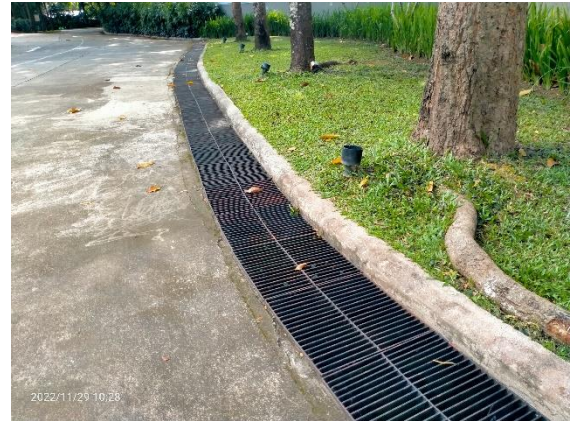
ตะแกรงเหล็กครอบรางระบายน้ำ
