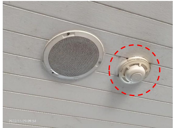
รูปที่ 2.10-2 Smoke Detector บริเวณภายในอาคาร
