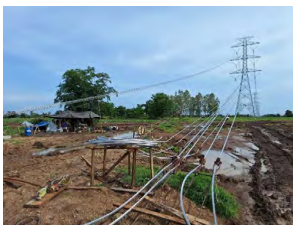
รูปที่ 3 ภาพแสดงกิจกรรมติดตั้งสายไฟฟ้าแรงสูงบริเวณฐานรากคันที่ 32 ในเขตตำบลอุ้มบุญ อำเภوتاตะโก จังหวัดนครสวรรค์
