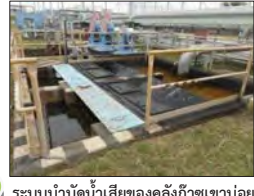
ระบบบำบัดน้ำเสียของคลังก๊าซบ่อยา
