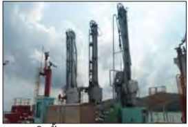
ติดตั้งระบบ Vapor Return บริเวณท่าเทียบเรือ
