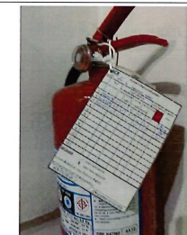
ภาพที่ 47 การตรวจสอบถังดับเพลิง
