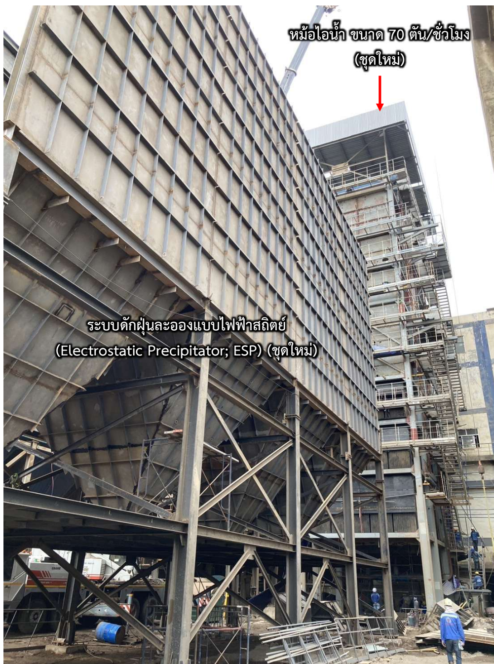
หม้อไอน้ำ ขนาด 70 ตัน/ชั่วโมง (ชุดใหม่) และระบบดักฝุ่นละอองแบบไฟฟ้าสถิตย์ (Electrostatic Precipitator; ESP) (ชุดใหม่) ปัจจุบันโครงการอยู่ระหว่างดำเนินการขออนุญาตก่อสร้างจากสำนักงานคณะกรรมการกำกับกิจการพลังงาน (กกพ.)
