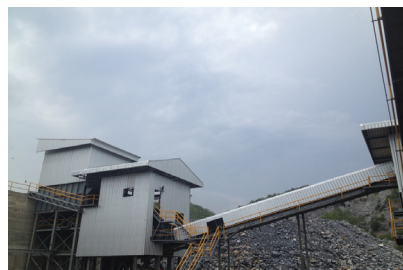
การปิดคลุมอาคารโรงโม่หินและสายพานลำเลียงอย่างมิดชิด
