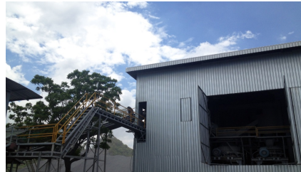
ปิดคลุมเครื่องจักรและสายพานลำเลียงเพื่อลดฝุ่นและเสียง
