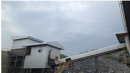
ปิดคลุมเครื่องจักรและสายพานลำเลียงเพื่อลดฝุ่นและเสียง
