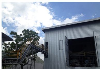
การปิดคลุมอาคารโรงโม่หินและสายพานลำเลียงอย่างมิดชิด
