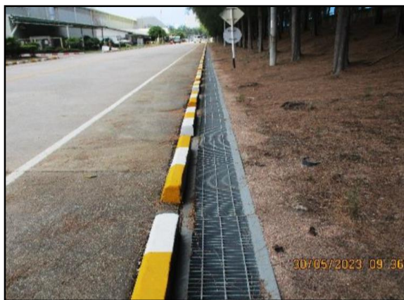
รูปที่ 12 วางระบายน้ำฝนรอบพื้นที่โครงการฯ
