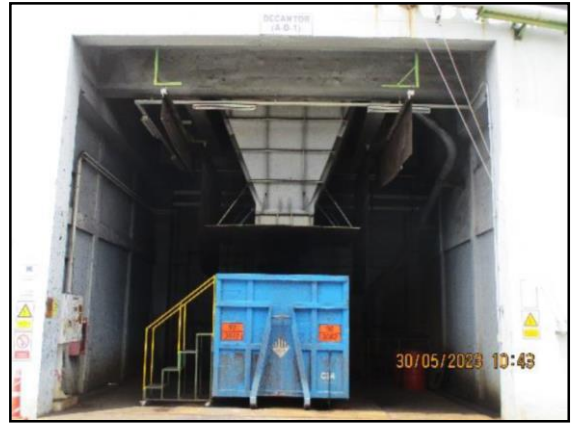
รูปที่ 15 ถังเก็บ (Hopper) สำหรับรวบรวมตะกอนจากระบบบำบัดน้ำเสีย
