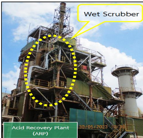
รูปที่ 3 ระบบควบคุมมลสาร (Scrubber) ของ Acid Recovery Plant (ARP) และ Pickling Line (PL)
