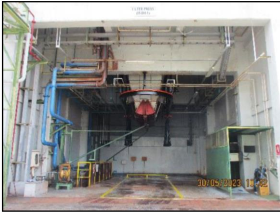
รูปที่ 15 ถังเก็บ (Hopper) สำหรับรวบรวมตะกอนจากระบบบำบัดน้ำเสีย
