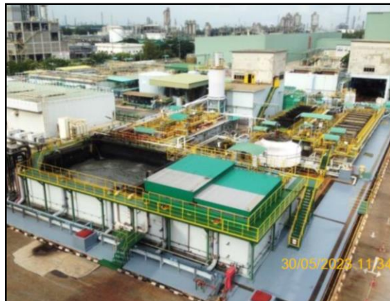
รูปที่ 7 ระบบบำบัดน้ำเสียเบื้องต้น
