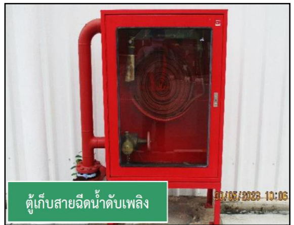
รูปที่ 28 การติดตั้งอุปกรณ์ดับเพลิงภายในพื้นที่โครงการฯ
