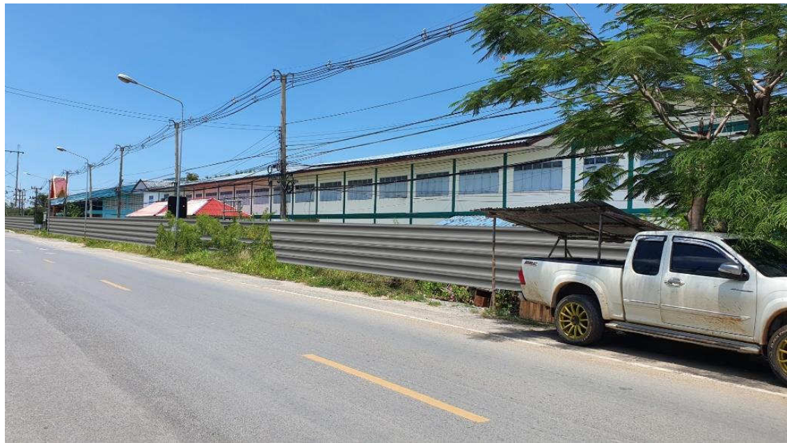
รูปที่ 6.2-6 ตัวอย่างการติดตั้งกำแพงกันเสียงชั่วคราว ความสูง 2.5 เมตร
