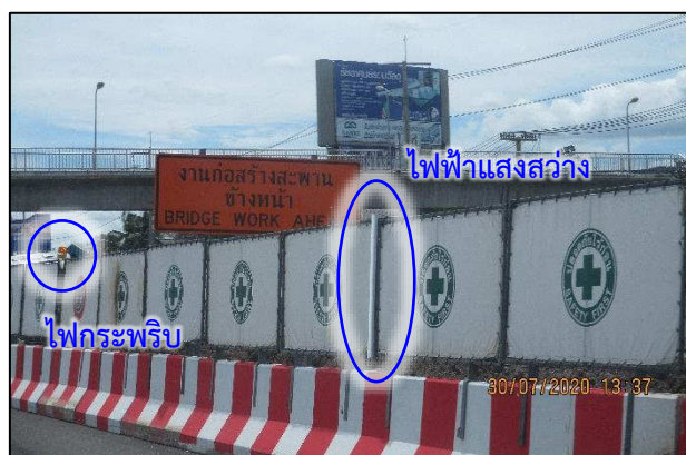
รูปที่ 5.2-16 ตัวอย่างการติดตั้งไฟฟ้าแสงสว่าง/ไฟกระพริบบนแผงคอนกรีต
