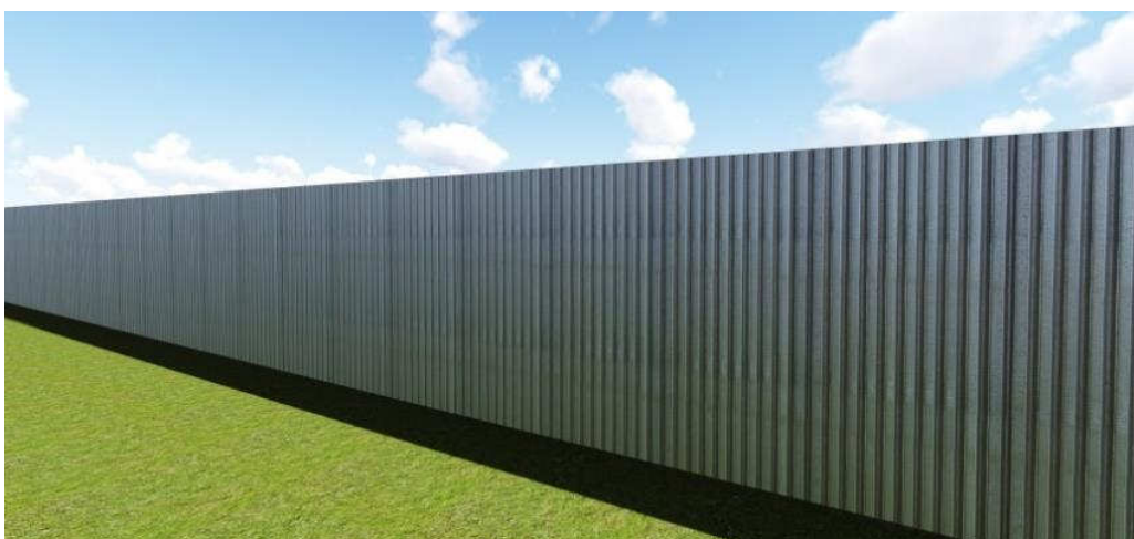
รูปที่ 5.2-5 ตัวอย่างลักษณะการติดตั้งกำแพงกันเสียงชั่วคราว
