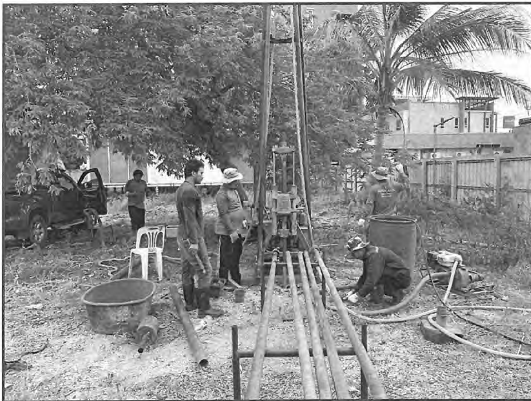
รูปที่ ๑-5 การเจาะสำรวจสภาพชั้นดินของหลุมเจาะ BH-3
