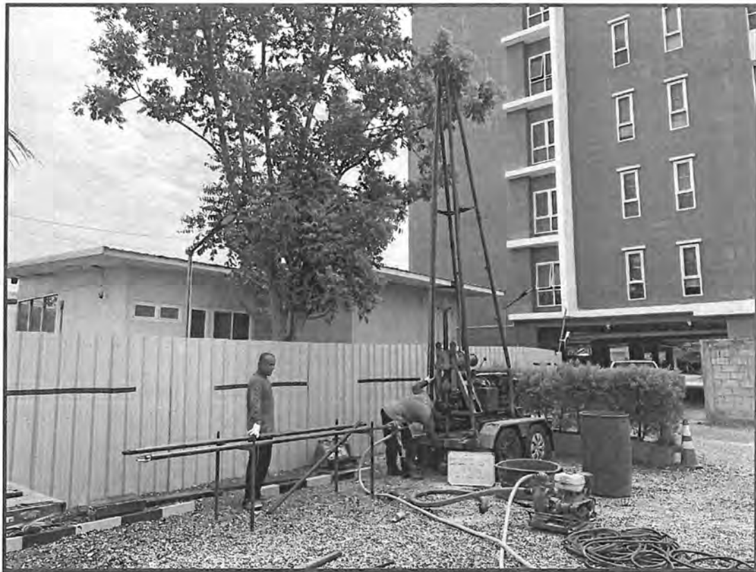
รูปที่ ฉ-1 การเจาะสำรวจสภาพชั้นดินของหลุมเจาะ BH-1
