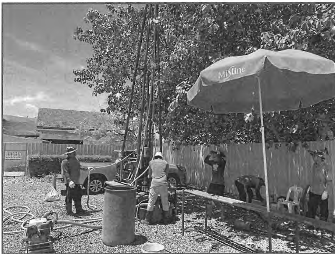
รูปที่ ๓-8 การเจาะสำรวจสภาพชั้นดินของหลุมเจาะ BH-4
