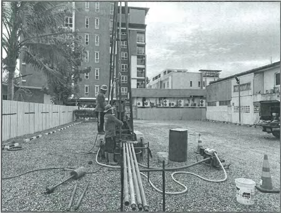
รูปที่ ฉ-3 การเจาะสำรวจสภาพชั้นดินของหลุมเจาะ BH-2
