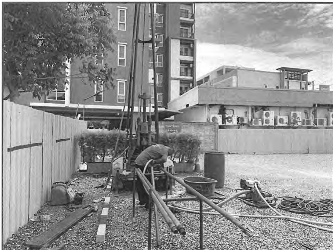
รูปที่ ฉ-2 การเจาะสำรวจสภาพชั้นดินของหลุมเจาะ BH-1
