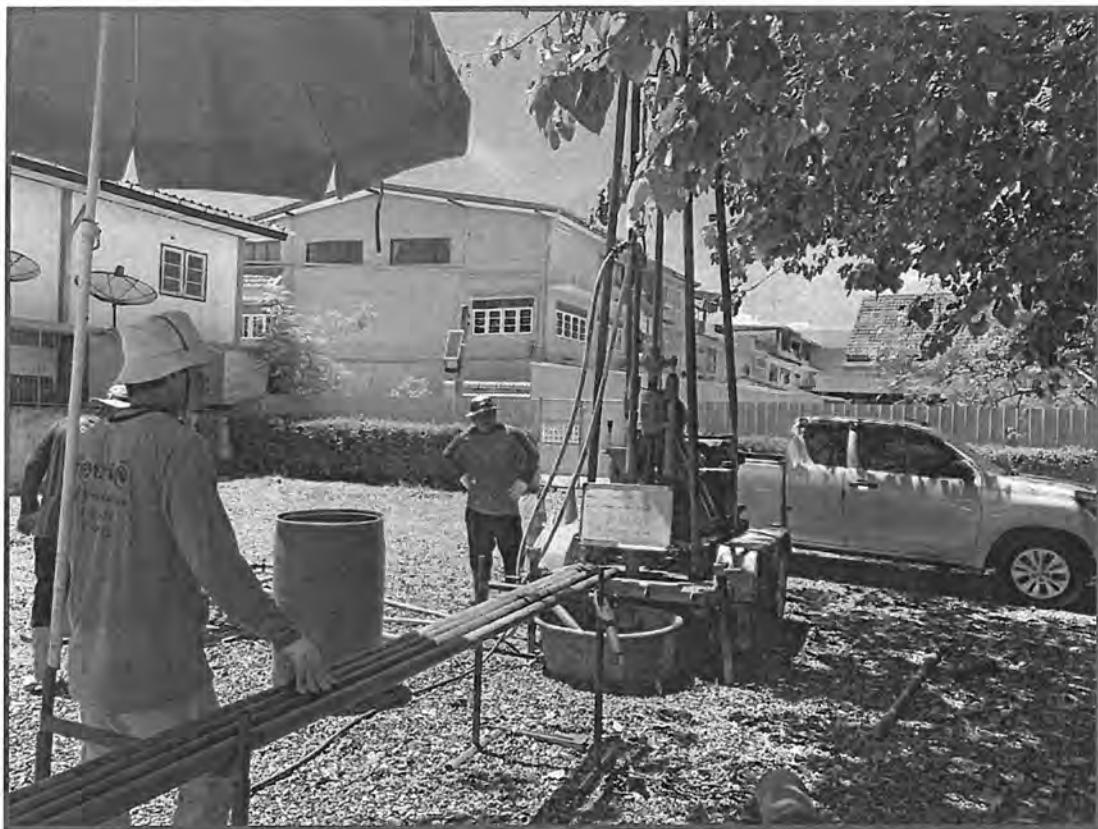
รูปที่ ๓-7 การเจาะสำรวจสภาพชั้นดินของหลุมเจาะ BH-4
