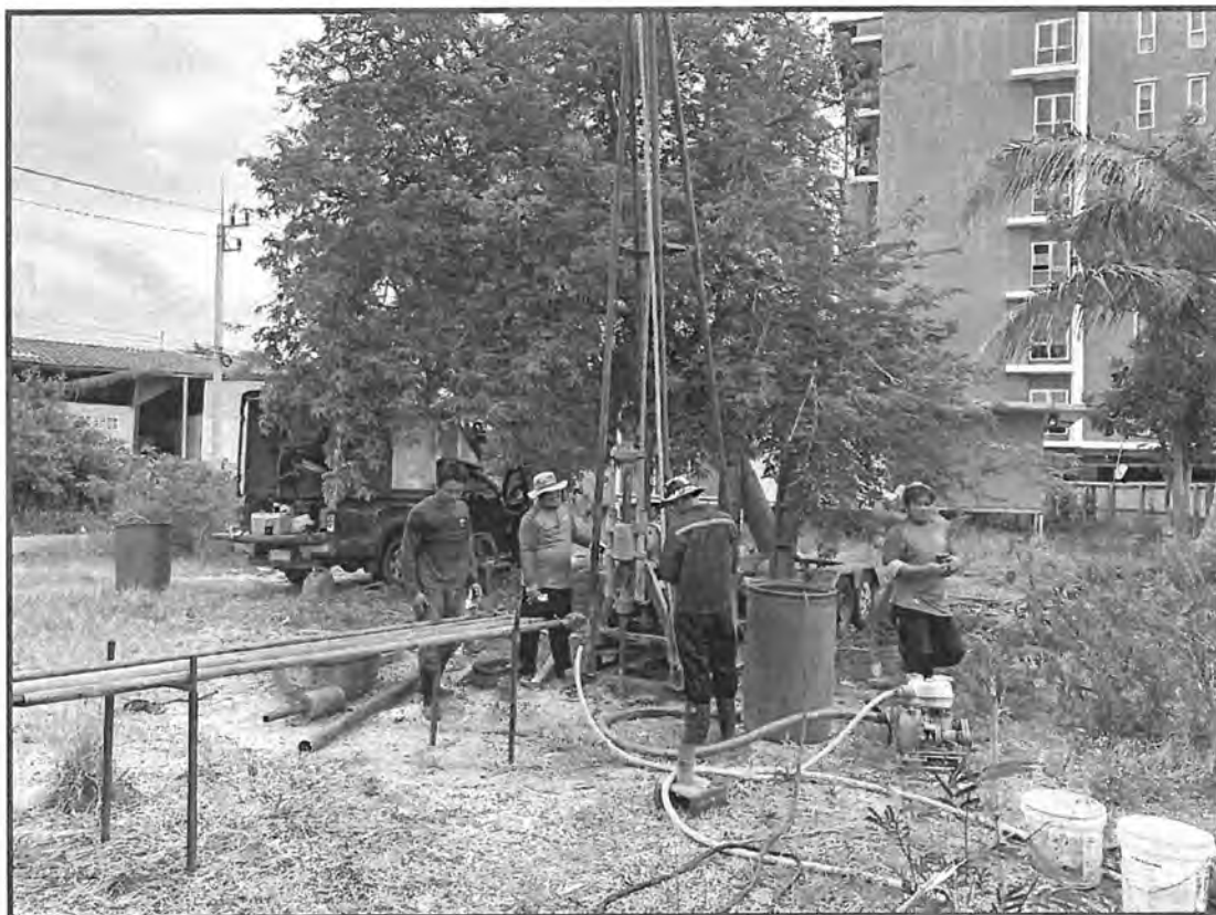
รูปที่ ๑-6 การเจาะสำรวจสภาพชั้นดินของหลุมเจาะ BH-3
