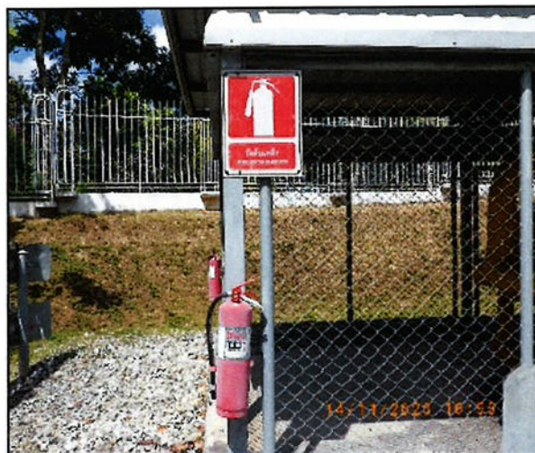
รูปที่ 47 เครื่องดับเพลิงชนิดผง (Powder Extinguisher) บริเวณสถานีควบคุมก๊าซฯ
