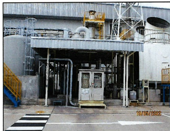
ภาพที่ 4 ระบบบำบัดมลพิษอากาศ แบบระบบหอดูดซึม (Spray Tower)
