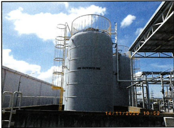
รูปที่ 11 ถังพักน้ำทิ้งจากการล้างย้อนระบบกรอง (Back wash waste Tank)
