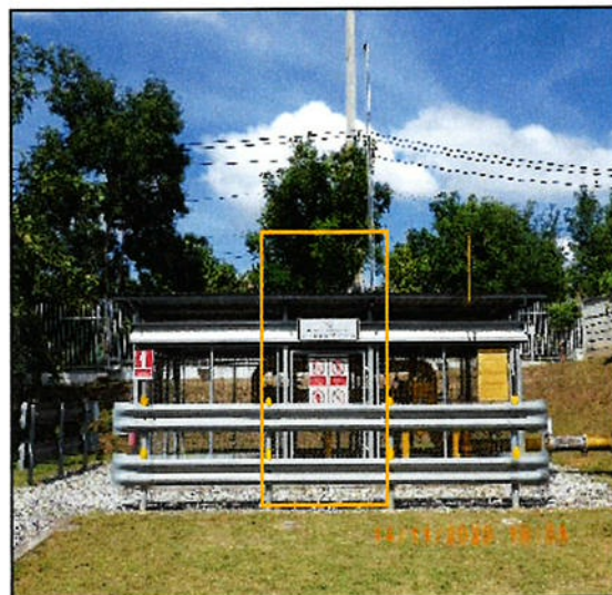
รูปที่ 43 ร้วตาข่ายโดยรอบสถานีควบคุม และมีประตูเข้า-ออก 2 ชั้น
