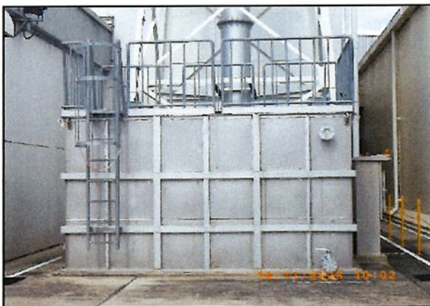
รูปที่ 9 ถังพักน้ำทิ้งจาก เตาอบละลาย
