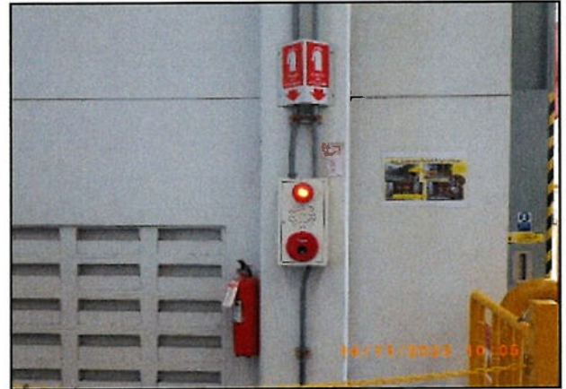
รูปที่ 39 สัญญาณเตือนภัย แบบอัตโนมัติ
