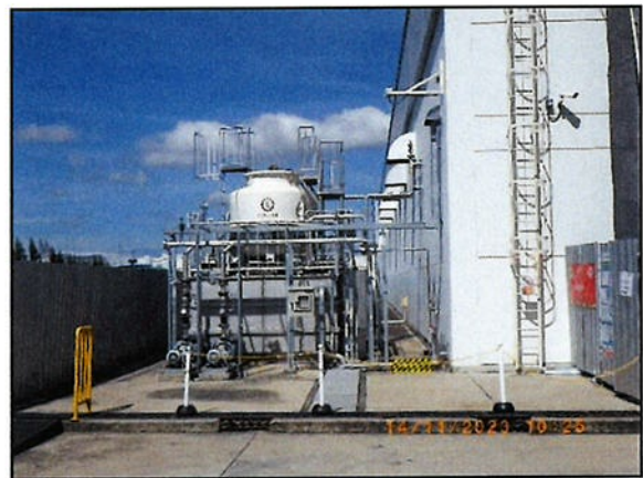
รูปที่ 16 ถังพักน้ำหมุนเวียนจากระบบหล่อเย็นของหน่วยยัดและม้วน (A8#2)
