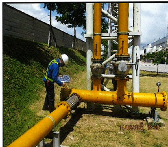
รูปที่ 48 การตรวจสอบแนวท่อและสถานีควบคุมโดยมีการตรวจเช็คโดยเจ้าหน้าที่ของโครงการฯ
