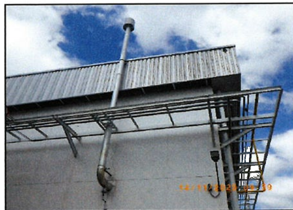
รูปที่ 2 ปล่องเตาอบอ่อน (Annealing Furnace)
