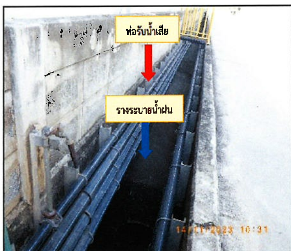
รูปที่ 26 ระบบระบายน้ำที่แยกออก จากรางระบายน้ำฝน
