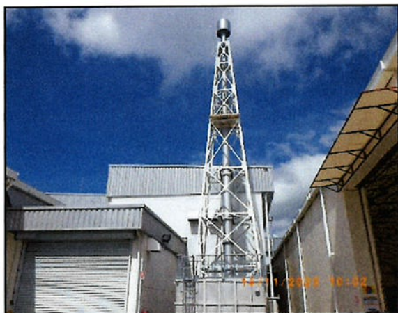
รูปที่ 3 ปล่องเตาอบละลาย (Solution Treatment Furnace)
