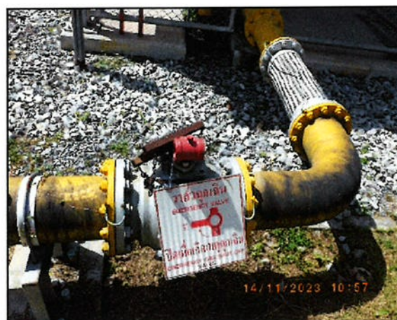
รูปที่ 45 ระบบท่อ Bypass และระบบวาล์วสำรอง
