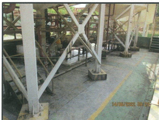
รูปที่ 47 สภาพพื้นคอนกรีตที่ตั้งถังกักเก็บวัสดุที่ไม่ใช่แล้วที่เป็นของเหลว
