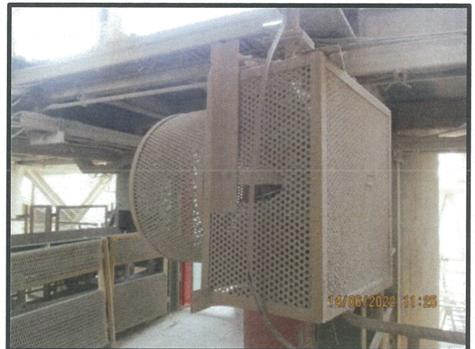
รูปที่ 51 พัฒนาระบายอากาศบริเวณลำเลียงและป้อนวัสดุที่ไม่ใช้แล้วเข้าหม้อเผาทาง Inlet Chamber
