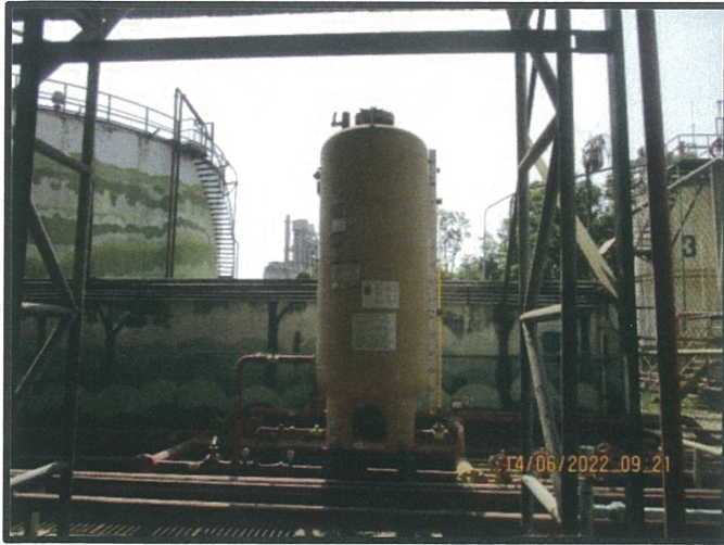
รูปที่ 49 ระบบดับเพลิงบริเวณถังเก็บวัสดุที่ไม่ใช้แล้วที่เป็นของเหลว
