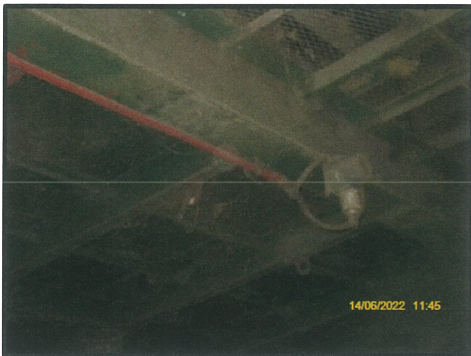
รูปที่ 55 ระบบตรวจจับก๊าซ (Gas Detector) บริเวณอาคาร Gasifier
