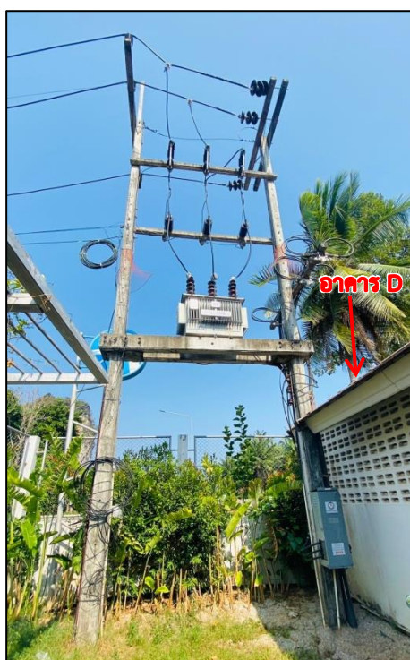
2.9.7-1 หม้อแปลงไฟฟ้าภายในโครงการ
