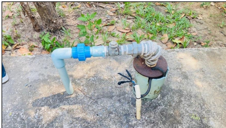
รูปที่ 2.9.1-1 บ่อน้ำของโครงการ ลึกประมาณ 13 เมตร
