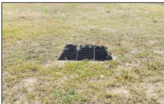
รูปที่ 2.9.4-1 ท่อระบายน้ำฝนภายในโครงการ
