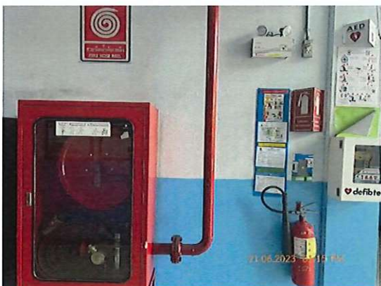
ภาพที่ 59 ท่อยื่นและตู้สายฉีดน้ำดับเพลิง
