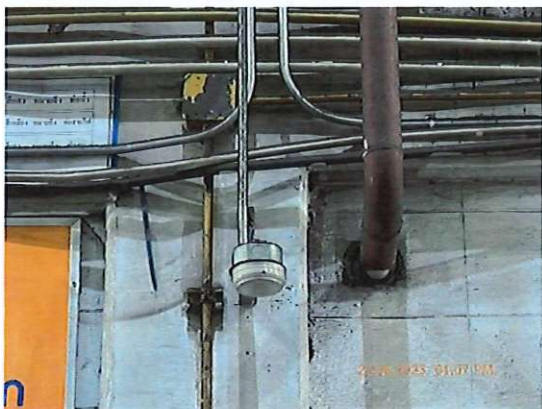
ภาพที่ 57 อุปกรณ์ตรวจจับความร้อนอัตโนมัติ
