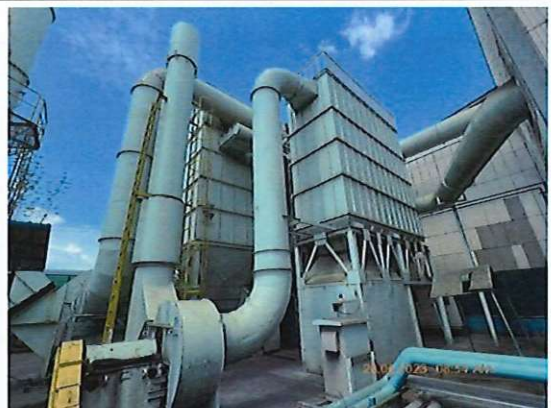
ภาพที่ 12 ปล่องระบบดักฝุ่นจากขั้นตอนการเทแบบ
