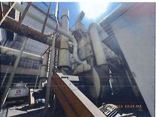
ภาพที่ 5 ปล่องระบบดักฝุ่นจาก Molding line (Line ACE)
