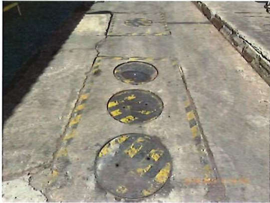
ภาพที่ 25 ระบบบำบัดน้ำเสียสำเร็จรูป
