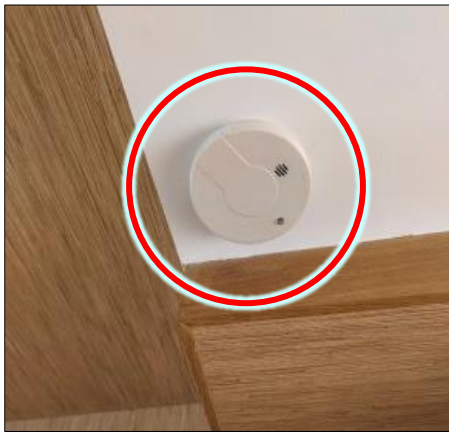
อุปกรณ์ตรวจจับควัน (Smoke Detector : SD)
