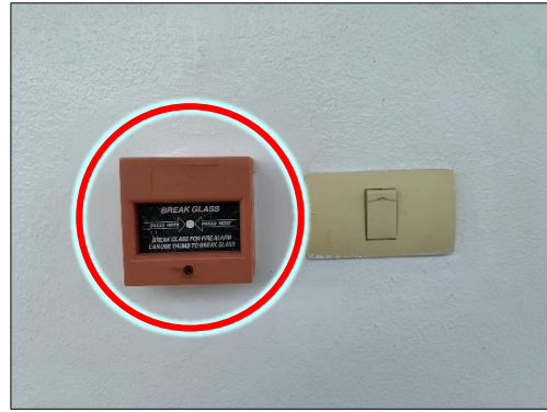
อุปกรณ์แจ้งเหตุด้วยมือ (Manual Call Point : M)
