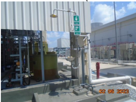
ภาพที่ 2.2-25 อุปกรณ์ชำระล้างฉุกเฉิน (Emergency Shower and Eye Wash Fountain)
