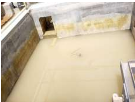
ภาพที่ 2.2-14 บ่อดักตะกอนก่อนระบายน้ำออกนอกพื้นที่โครงการ
