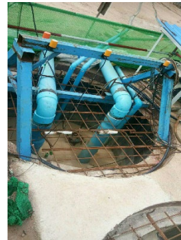
ภาพที่ 2.2-13 ระบบบำบัดน้ำเสียสำเร็จรูป
