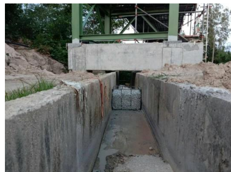
ภาพที่ 2.2-15 จุดดักตะกอนก่อนระบายน้ำออกนอกพื้นที่โครงการ
