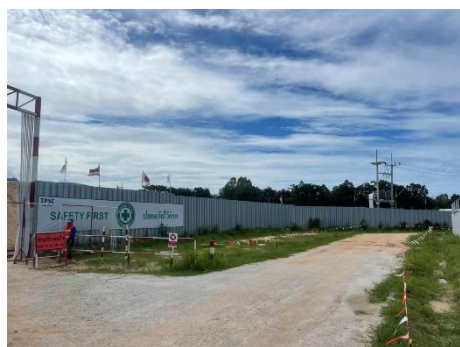
ภาพที่ 2.2-8 กำแพงกันเสียงรอบพื้นที่โครงการ
