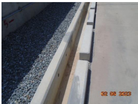
ภาพที่ 2.2-17 ระบบระบายน้ำฝนภายในพื้นที่โครงการ
