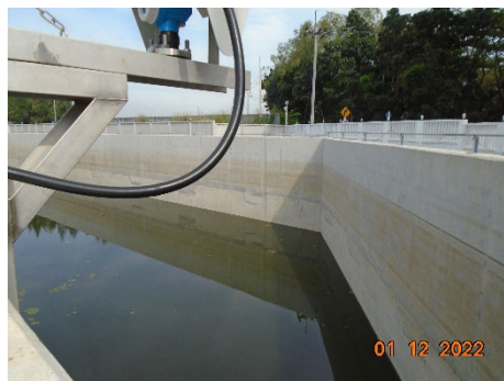
ภาพที่ 2.2-11 บ่อดักตะกอนก่อนระบายน้ำออกนอกพื้นที่โครงการ
