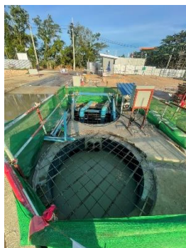
ภาพที่ 2.2-14 บ่อดักตะกอนก่อนระบายน้ำออกนอกพื้นที่โครงการ
