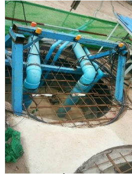
ภาพที่ 2.2-17 ระบบบำบัดน้ำเสียสำเร็จรูป
