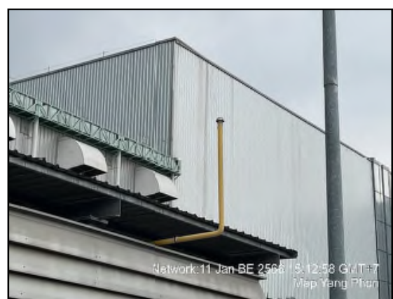
รูปที่ 39 ปล่องระบายก๊าซ (Blow down stack)
