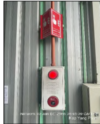
รูปที่ 31 ระบบตรวจจับและสัญญาณเตือนภัย
