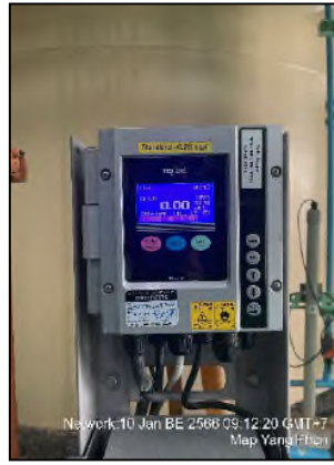
รูปที่ 7 ตัวอย่างระบบตรวจวัดคุณภาพน้ำอัตโนมัติ
