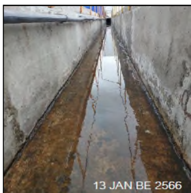
รูปที่ 19 รางระบายน้ำฝนในพื้นที่โครงการ
