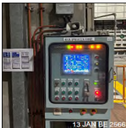
รูปที่ 34 COMBINATION BOX W/MANUAL STATION LOCATION LAMP&ALARM BELL บริเวณเตาหลอม
