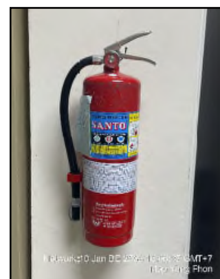
รูปที่ 41 เครื่องดับเพลิงชนิดผง (Power Extinguisher)
