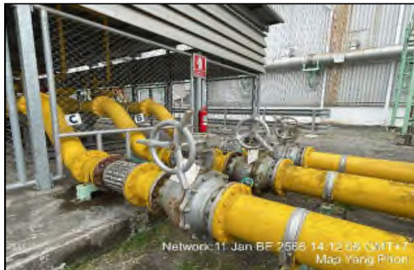
รูปที่ 37 Insulation Joint/Flang
