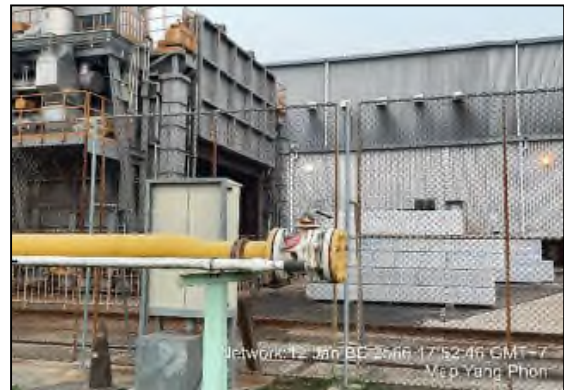
รูปที่ 37 Insulation Joint/Flang
