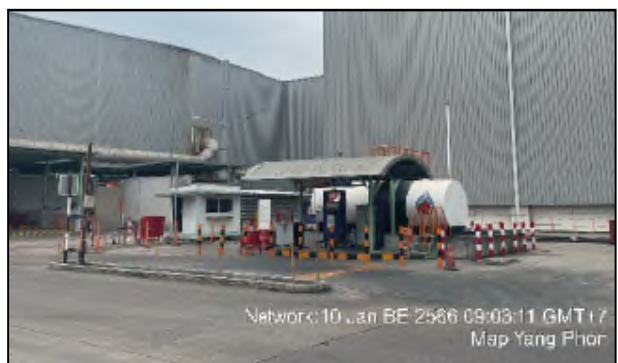
รูปที่ 35 ถังเก็บน้ำมันดีเซล
