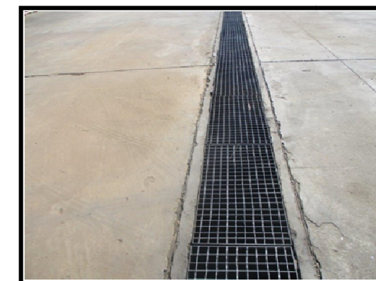
ภาพถ่ายรางระบายน้ำ เพื่อรองรับน้ำเสียที่ปนเปื้อนกากของเสียรั่วไหล
