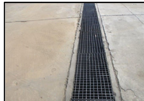
ตัวอย่างภาพถ่ายรางระบายน้ำ เพื่อรองรับน้ำเสียที่ปนเปื้อนกากของเสียรั่วไหล
