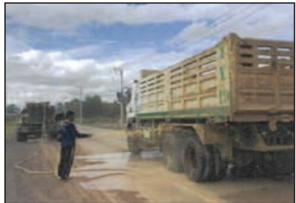
รูปที่ 4 การทำความสะอาดล้อรถบรรทุก
