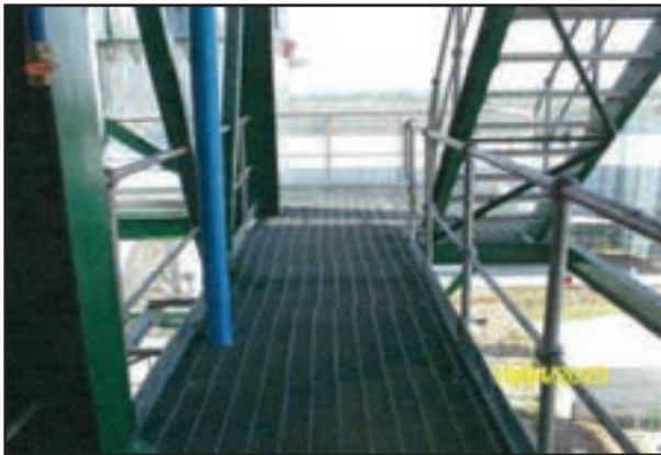
บันไดและทางเดินสำหรับหม้อไอน้ำ
