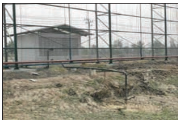
รูปที่ 45 ระบบรวบรวมน้ำชะลานกองเถ้า
