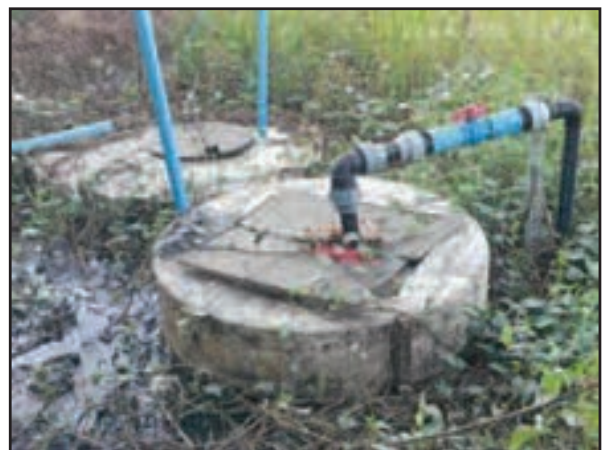
รูปที่ 6 ระบบถังเกรอะ-กรองไร้อากาศ
