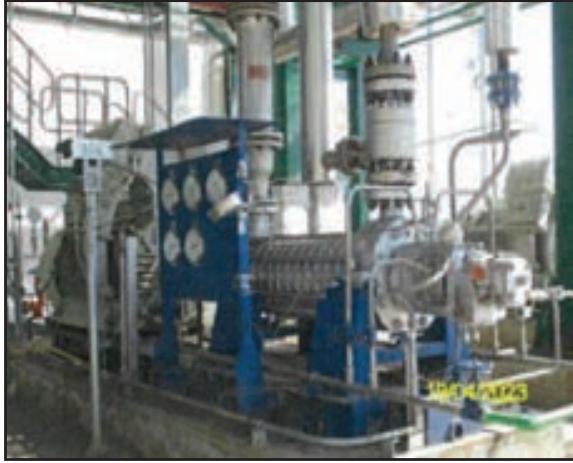
เครื่องสูบน้ำป้อนหม้อไอน้ำ
