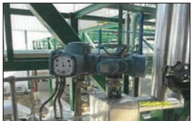
ลิ้นระบายไอน้ำ (Blow down Valve)
