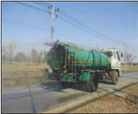
รูปที่ 1 การฉีดพรมน้ำเพื่อลดการฟุ้งกระจาย ของฝุ่นระอบบริเวณพื้นที่ก่อสร้าง
