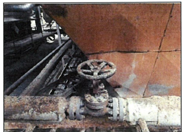
ลิ้นระบายหม้อไอน้ำ (Blow down Valve)
