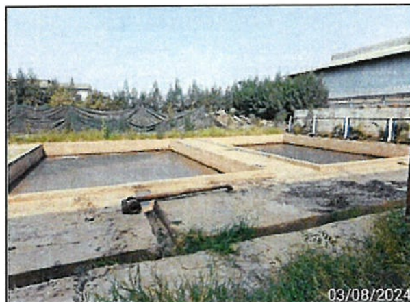
รูปที่ 19 บ่อพักน้ำทิ้งคอนกรีตรองรับน้ำทิ้ง จากระบบหล่อเย็น
