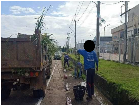
รูปที่ 2-31 การขุดลอกตะกอนในรางระบายน้ำฝน
