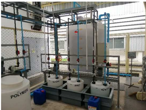
รูปที่ 2-19 ระบบบำบัดน้ำเสียขั้นต้นของโรงงาน
