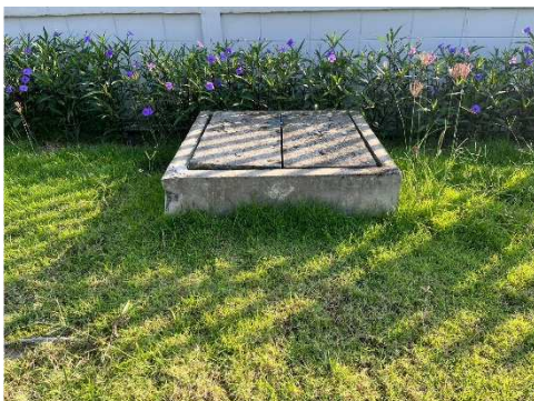
รูปที่ 2-21 Inspection Manhole
