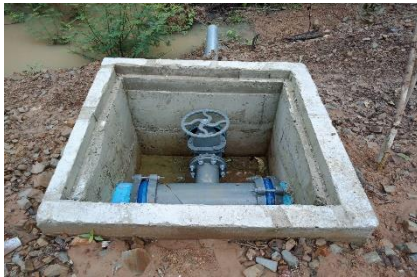
รูปที่ 3.4.2-5 การส่งน้ำโดยระบบท่อส่งน้ำขนาดเส้นผ่าศูนย์กลาง 0.30 เมตร
