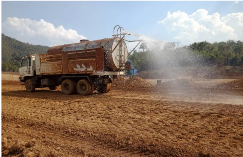
รูปที่ 2.7-3 การฉีดพรมน้ำในพื้นที่ก่อสร้าง
