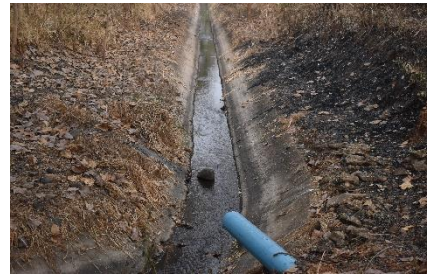
รูปที่ 3.4.2-5 การส่งน้ำโดยระบบท่อส่งน้ำขนาดเส้นผ่าศูนย์กลาง 0.30 เมตร
