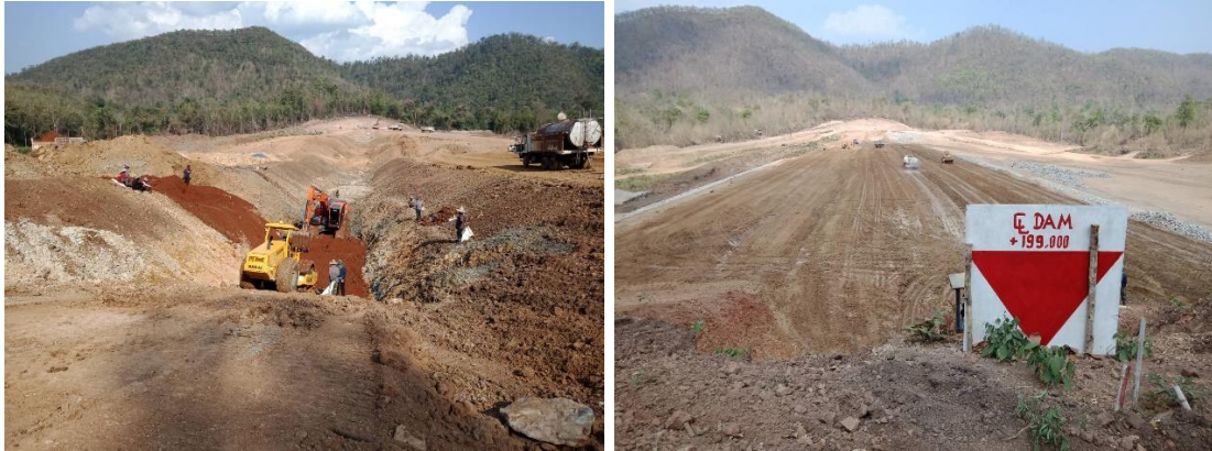
รูปที่ 2.7-5 การขุดเปิดร่องแกนเขื่อนและพื้นที่อ่างเก็บน้ำ
