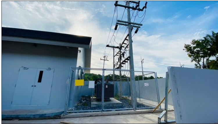
หม้อแปลงไฟฟ้าแบบตั้งพื้นภายนอกอาคาร ขนาด 1,500 kVA
