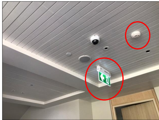
อุปกรณ์ตรวจจับควัน (Smoke Detector : SD) ป้ายทางออกฉุกเฉิน (Emergency Exit Signs)
