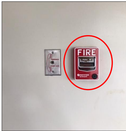
อุปกรณ์แจ้งเหตุด้วยมือ (Manual Call Point : M)
