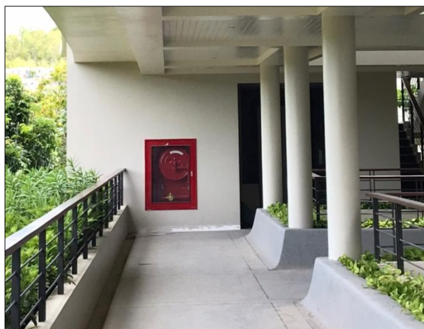
รูปที่ 2.9.8.2-2 ตู้สายฉีดน้ำดับเพลิง (FIRE HOSE CABINET : FHC)
