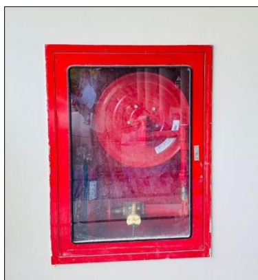
รูปที่ 2.9.8.2-2 ตู้สายฉีดน้ำดับเพลิง (FIRE HOSE CABINET : FHC)
