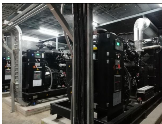
รูปที่ 2.9.7-5 ระบบไฟฟ้าสำรอง ขนาด 630 kVA ภายในห้อง Generator ของอาคารสำนักงาน
