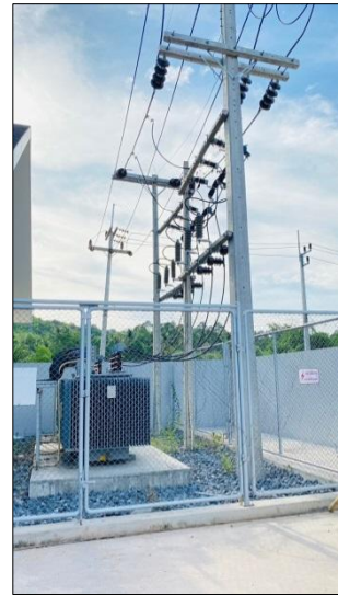
หม้อแปลงไฟฟ้าแบบตั้งพื้นภายนอกอาคาร ขนาด 1,500 kVA
