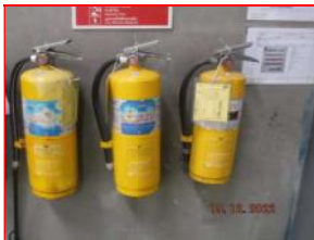
ภาพที่ 2.2-35 ถังดับเพลิง Class D บริเวณโรงคัดแยกเศษอะลูมิเนียม
