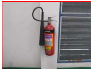
ภาพที่ 2.2-36 ถังดับเพลิงชนิด CO บริเวณโรงคัดแยกเศษอะลูมิเนียม
