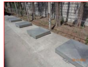
๗ ภาพที่ 2.2 16 บ่ออัดตะกอน - บริเวณพื้นที่เศษอะลูมิเนียม
