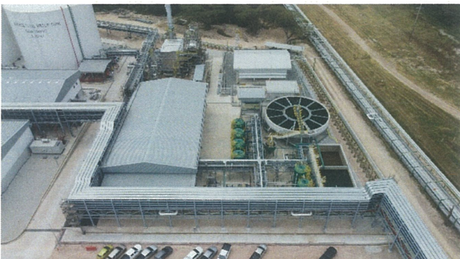
ระบบผลิตน้ำกรองและน้ำปราศจากแร่ธาตุ, ระบบตกตะกอนเบื้องต้น
