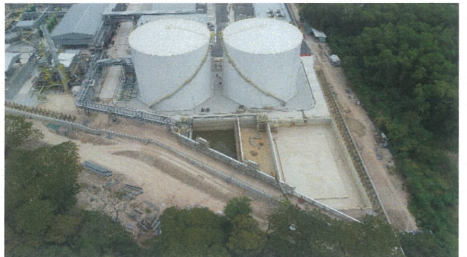
บ่อหนองน้ำฝน, ถังเก็บน้ำกรองและน้ำปราศจากแร่ธาตุ
