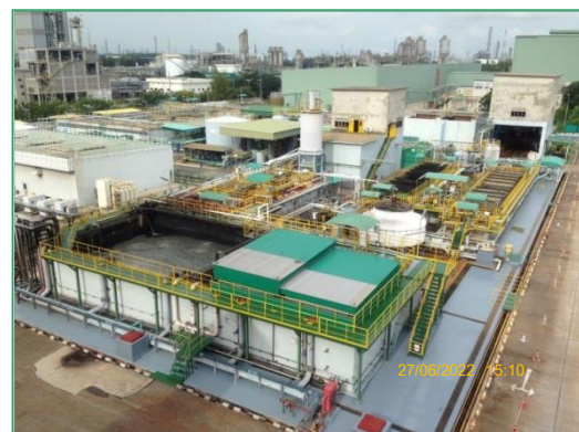
ภาพที่ 2.7 ระบบบำบัดน้ำเสียเบื้องต้น
