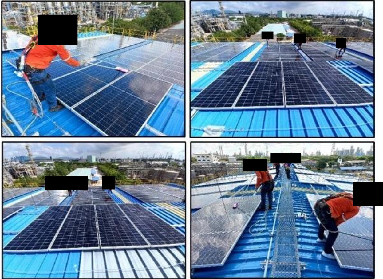
ภาพที่ 2.4-6 ตัวอย่างการทำความสะอาดแผงเซลล์แสงอาทิตย์
