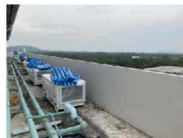
รูปที่ 2.6.6-1 หน่วยระบบระบายอากาศ (Exhaust Air Unit) เพื่อเติมอากาศด้วยอากาศบริสุทธิ์ (Fresh Air)
