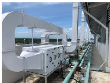
รูปที่ 2.6.6-1 หน่วยระบบระบายอากาศ (Exhaust Air Unit) เพื่อเติมอากาศด้วยอากาศบริสุทธิ์ (Fresh Air)
