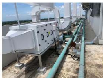
รูปที่ 2.6.6-1 หน่วยระบบระบายอากาศ (Exhaust Air Unit) เพื่อเติมอากาศด้วยอากาศบริสุทธิ์ (Fresh Air)
