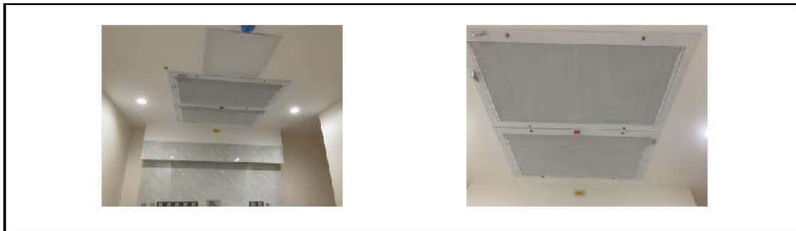
รูปที่ 2.6.6-3 ตัวอย่างการติดตั้งแผงกรองอากาศบริเวณแผนกผู้ป่วยวิกฤติ
