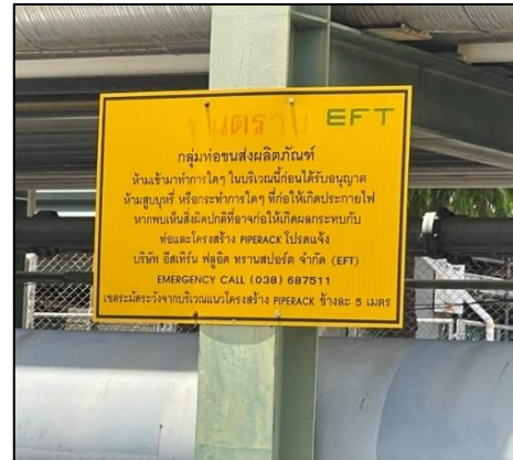
ตัวอย่างป้ายแสดงแนวท่อบริเวณโครงสร้างชั้นวางท่อ (Pipe Rack)
