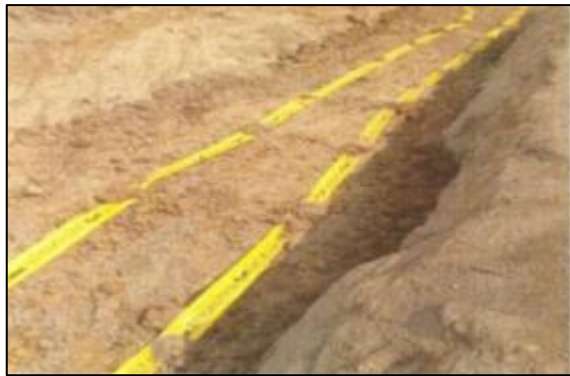
การติดตั้งแถบเตือนแนววางท่อและแผ่นคอนกรีตบนหลังท่อ
