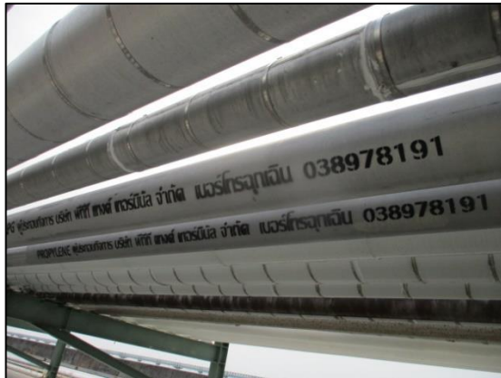
ตัวอย่างป้ายแสดงแนวท่อบริเวณโครงสร้างชั้นวางท่อ (Pipe Rack)
