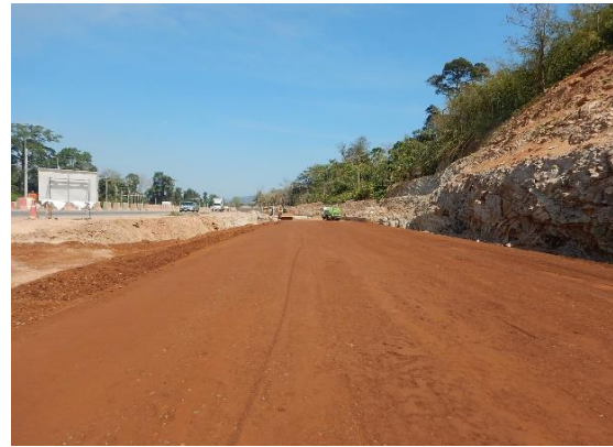
รูปที่ 5.2.4-1 ตัวอย่างดำเนินการเปิดพื้นที่ก่อสร้างเป็นช่วงๆ ตามความเหมาะสม
