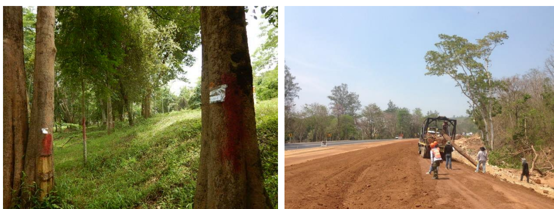
รูปที่ 5.3.3-1 การทำเครื่องหมายตัดฟันต้นไม้ในเขตทาง และการควบคุมทิศทางการล้มของไม้
