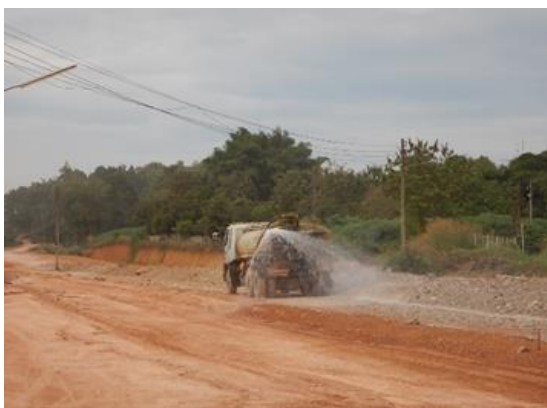
รูปที่ 5.2.4-2 การฉีดพรมน้ำลดการฟุ้งกระจายของฝุ่นละออง และติดป้ายจำกัดความเร็ว
