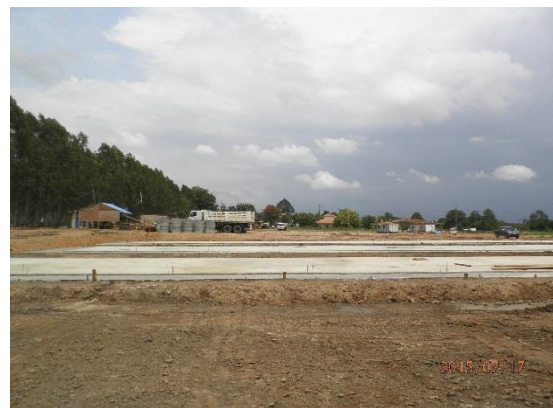
รูปที่ 5.2.3-5 ตัวอย่างการเทพื้นคอนกรีตในบริเวณที่อาจเกิดการรั่วไหลของน้ำมันและไขมัน
