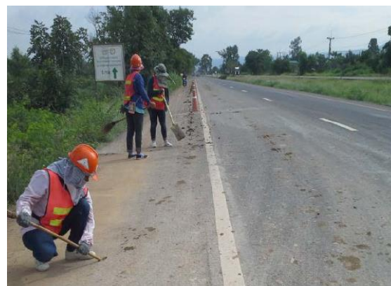
รูปที่ 5.2.4-3 การปิดคลุมท้ายรถบรรทุก และการทำความสะอาดเศษดินที่ตกหล่น
