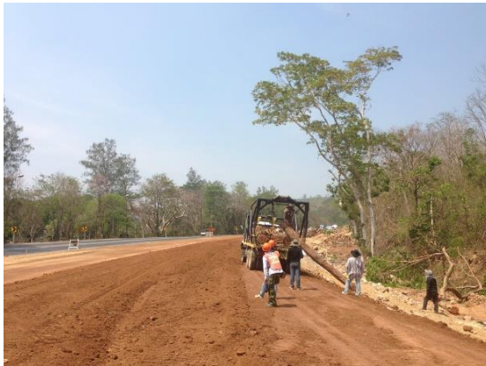
รูปที่ 5.2.4-1 ตัวอย่างดำเนินการเปิดพื้นที่ก่อสร้างเป็นช่วงๆ ตามความเหมาะสม
