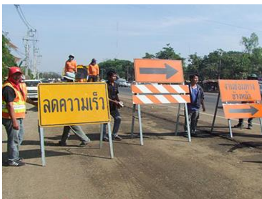
รูปที่ 5.4.1-3 การจัดเจ้าหน้าที่อำนวยความสะดวกในกรณีที่ทำทางเบี่ยง หรือปิดแนวเส้นทาง
