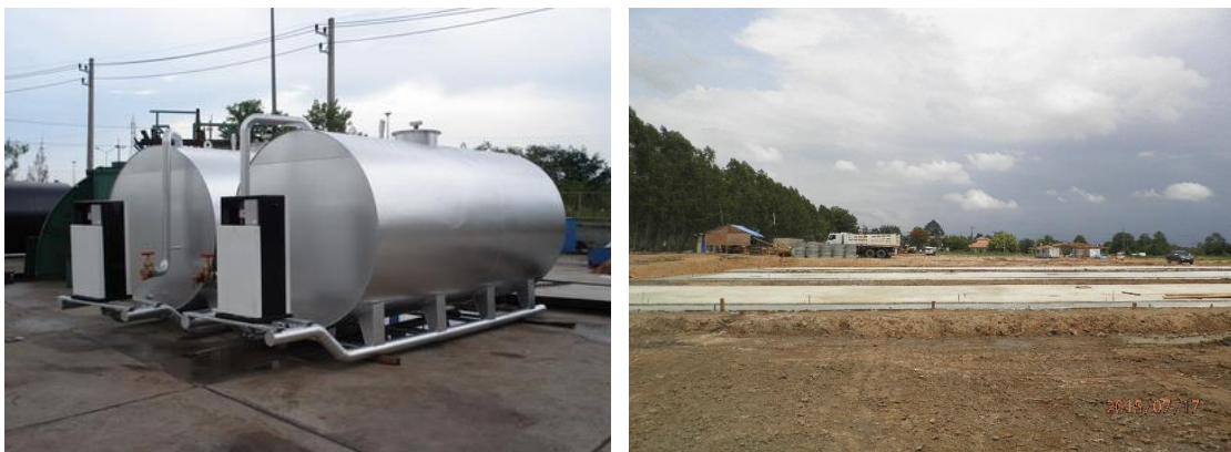
รูปที่ 7.2.3-5 ตัวอย่างการเทพื้นคอนกรีตในบริเวณที่อาจเกิดการรั่วไหลของน้ำมันและไขมัน
