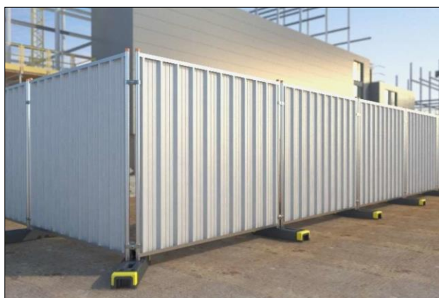
รูปที่ 4.1.5-3 ตัวอย่างแผ่นกั้นเสียงชั่วคราวชนิดเคลื่อนย้ายได้ (Aluminum Sheet)
