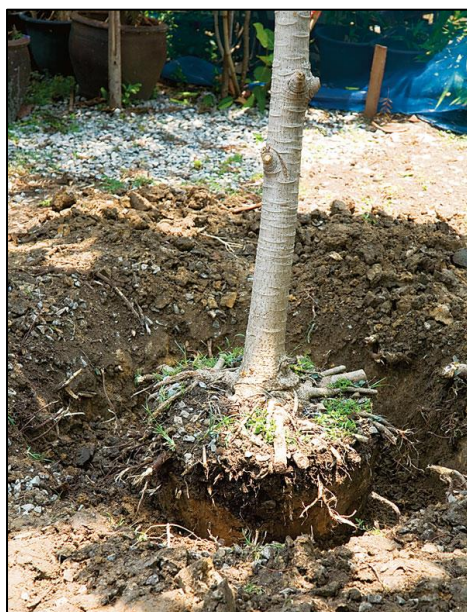
รูปที่ 2.11-2 ตัวอย่างการขุดล้อมและการตัดแต่งราก
