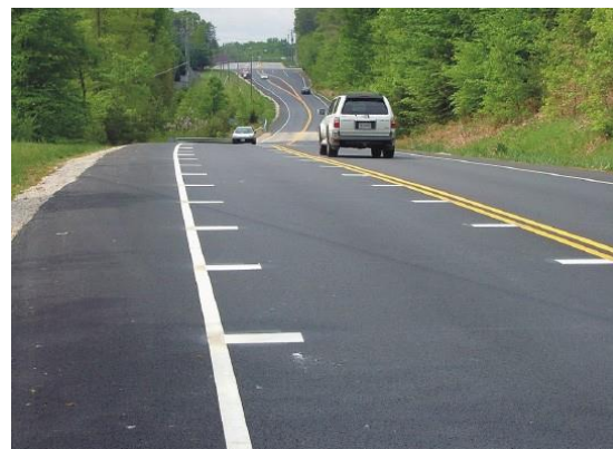
รูปที่ 2.5.7-1 ตัวอย่างการติดตั้งเส้นชะลอความเร็ว
