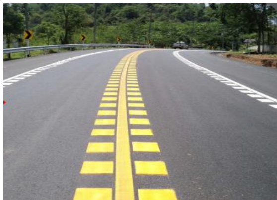
รูปที่ 2.5.7-1 ตัวอย่างการติดตั้งเส้นชะลอความเร็ว
