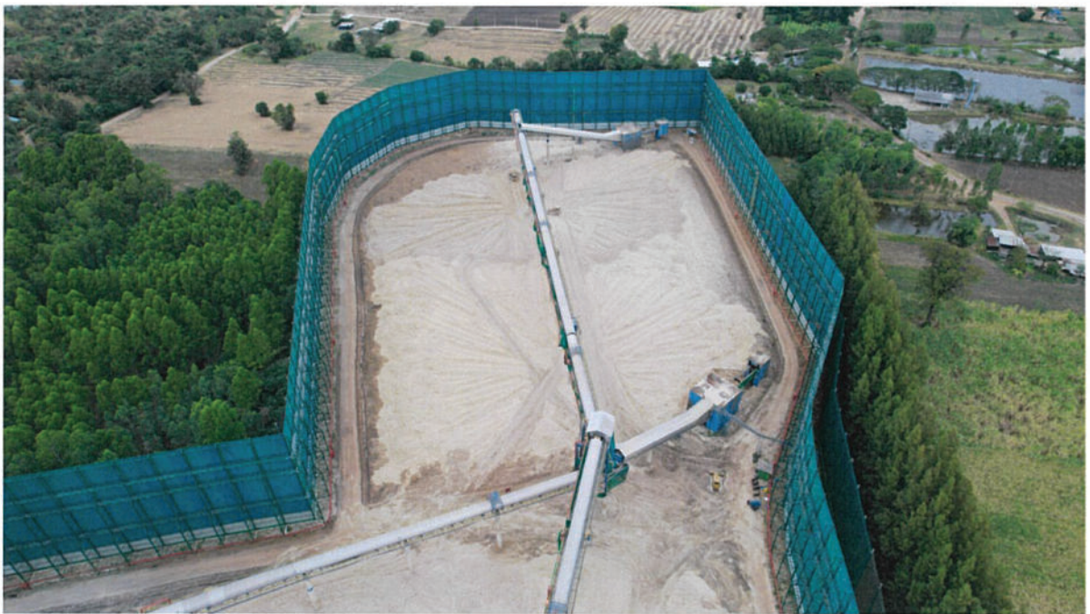
จุดที่ 4 ลานกองกากอ้อยลานนอก ทำการก่อสร้างติดตั้งแนวตาข่ายความสูง 27 เมตร (ดำเนินการเรียบร้อยแล้ว)
