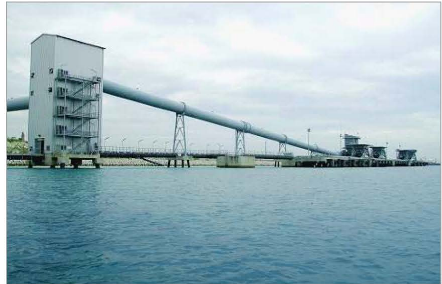
ระบบสายพานลำเลียงถ่านหิน (อยู่ในความรับผิดชอบของโครงการท่าเรือขนถ่ายถ่านหินของโรงไฟฟ้า ที่ดำเนินการโดยบริษัท โกลว์ เอสพีพี 3 จำกัด)
