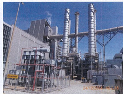
หน่วยผลิตไฟฟ้าแบบกังหันก๊าซที่ใช้ก๊าซธรรมชาติเป็นเชื้อเพลิง (Combustion Turbine Generator; CTG) ชุด CTG HRU 1A & 1B และ CTG HRU 2A & 2B
