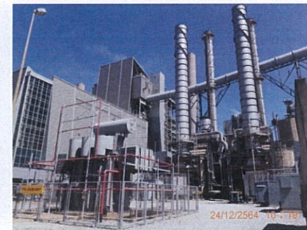
หน่วยผลิตไฟฟ้าแบบกังหันก๊าซที่ใช้ก๊าซธรรมชาติเป็นเชื้อเพลิง (Combustion Turbine Generator; CTG) ชุด CTG HRU 1A & 1B และ CTG HRU 2A & 2B
