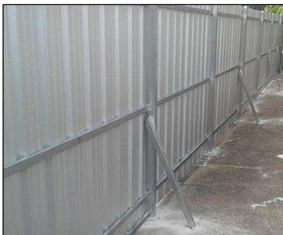
รูปที่ 7.2.3-3 ตัวอย่างลักษณะของกำแพงกันเสียงชั่วคราว Metal Sheet
