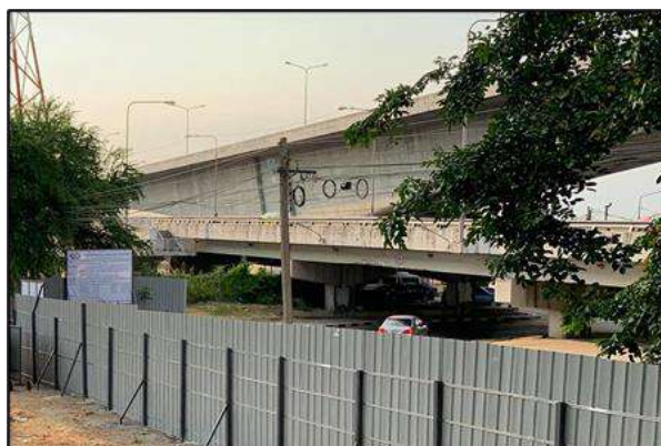
รูปที่ 7.2.3-3 ตัวอย่างลักษณะของกำแพงกันเสียงชั่วคราว Metal Sheet
