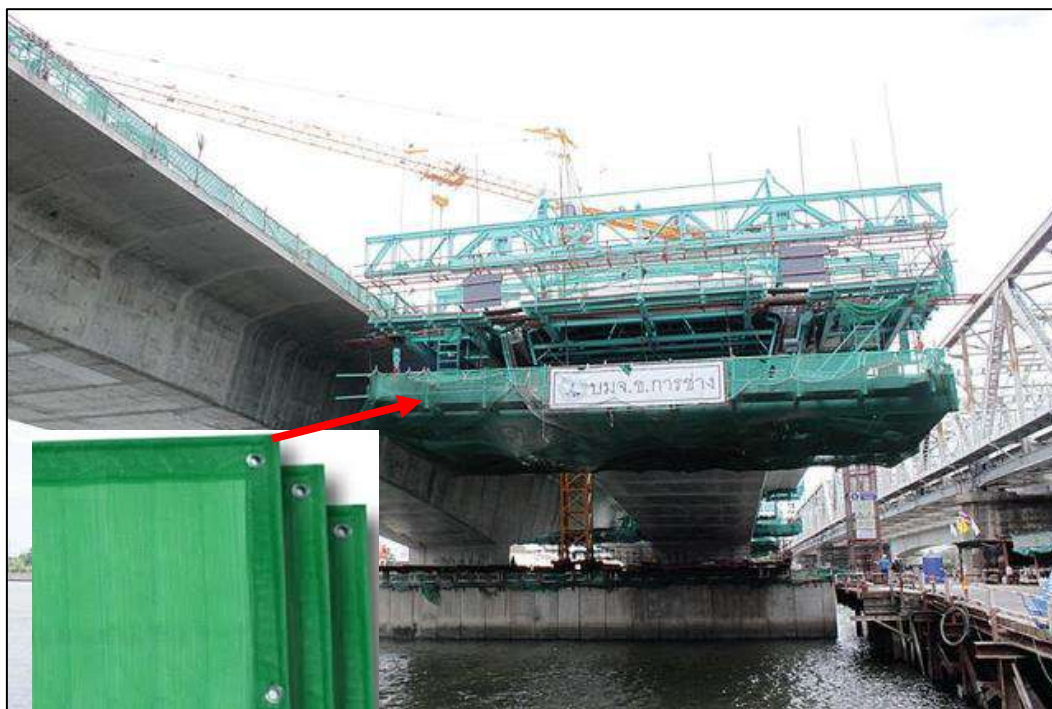
รูปที่ 7.2.1-1 ตัวอย่างการติดตั้งตาข่ายป้องกันการร่วงหล่นของเศษวัสดุก่อสร้าง
