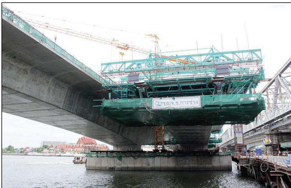
รูปที่ 5.2.3-1 ตัวอย่างการติดตั้งตาข่ายป้องกันการร่วงหล่นของเศษวัสดุก่อสร้าง
