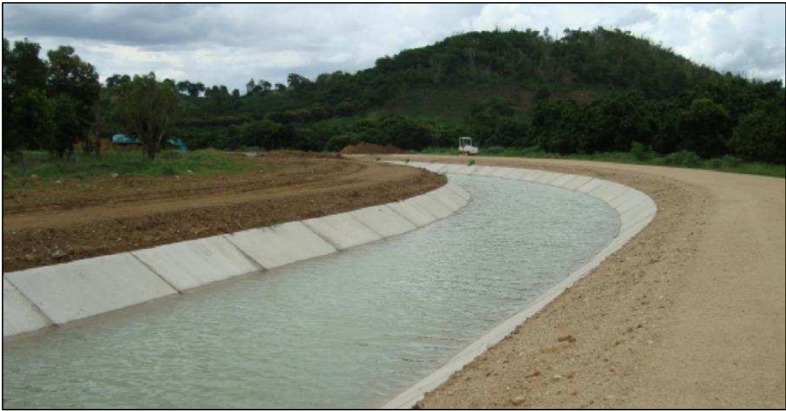
รูปที่ 1.5.5-2 รูปแบบระบบส่งน้ำที่เป็นคลองตาดคอนกรีต
