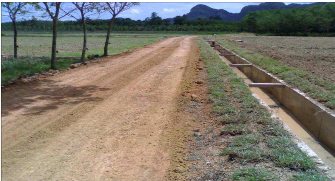
รูปที่ 1.5.5-3 รูปแบบระบบส่งน้ำที่เป็นแบบท่อส่งน้ำผสมกับคลองคอนกรีตเสริมเหล็ก (U-shape)
