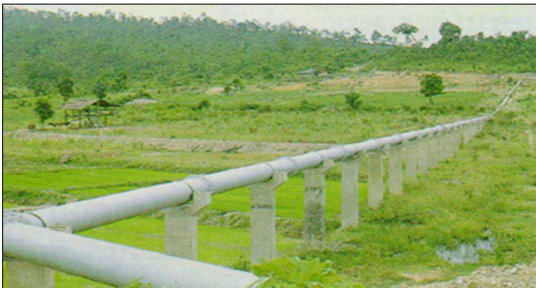
รูปที่ 1.5.5-1 รูปแบบระบบส่งน้ำที่เป็นท่อส่งน้ำ
