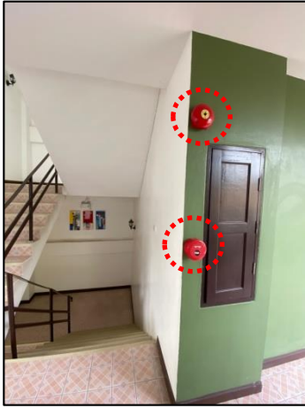
ภาพถ่ายอุปกรณ์แจ้งเหตุ และแจ้งเตือนเพลิงไหม้
