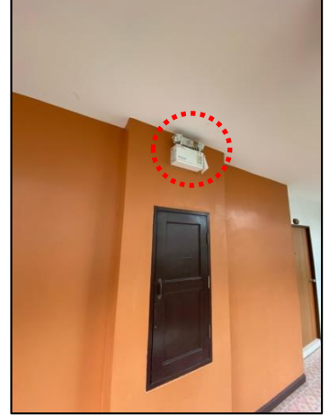
ภาพถ่ายไฟส่องสว่างฉุกเฉิน
