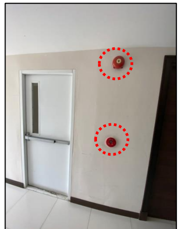
ภาพถ่ายอุปกรณ์แจ้งเหตุและ แจ้งเตือนเพลิงไหม้และประตูหนีไฟ
