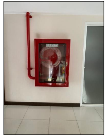
ภาพถ่ายตู้สายน้ำดับเพลิง และท่อเย็นน้ำดับเพลิง
