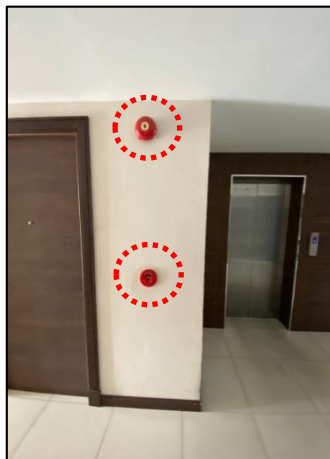
ภาพถ่ายอุปกรณ์แจ้งเหตุ และแจ้งเตือนเพลิงไหม้
