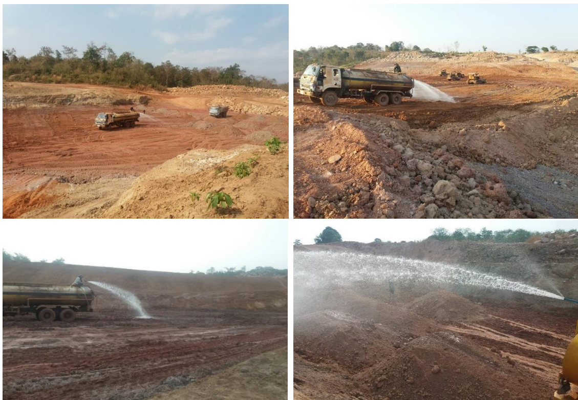
ภาพที่ 5.2.2-3 การฉีดพรมน้ำในพื้นที่ก่อสร้างเพื่อป้องกันฝุ่นละอองจากการก่อสร้าง
