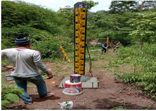
รูปที่ 7.3.2-3 การติดตั้งเสาวัดระดับน้ำ สถานี Kh.118 บ้านแก่งแต่ อ.คำชะอี จ.มุกดาหาร
