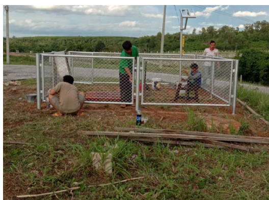
รูปที่ 7.3.1-2 การติดตั้งคอกกักอุตุ – อุทกวิทยา อ่างเก็บน้ำห้วยตาเปอะ บ้านห้วยตาเปอะ อ.คำชะอี
