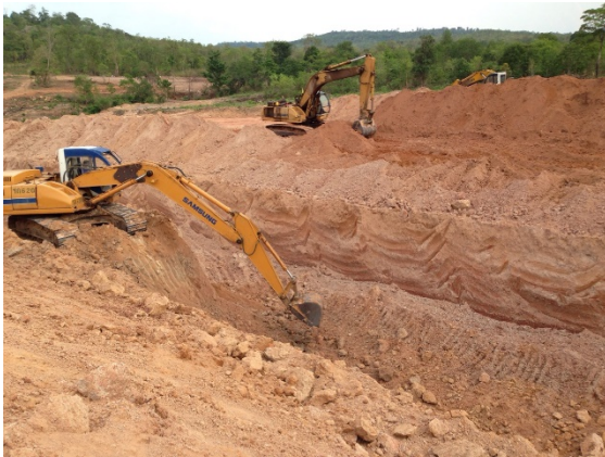
ภาพที่ 5.2.2-2 การขุดเปิดพื้นที่ส่วนใหญ่ให้แล้วเสร็จก่อนฤดูฝน
