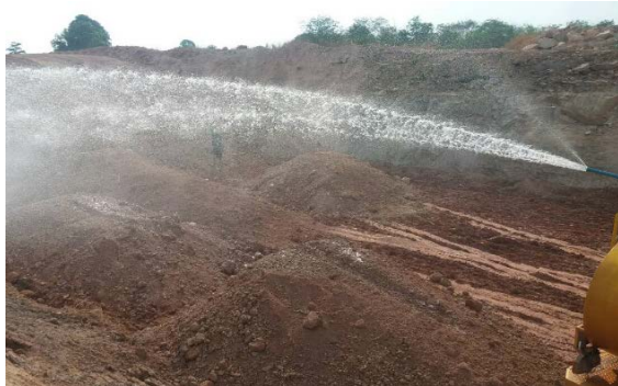
ภาพที่ 5.2.2-3 การฉีดพรมน้ำในพื้นที่ก่อสร้างเพื่อป้องกันฝุ่นละอองจากการก่อสร้าง
