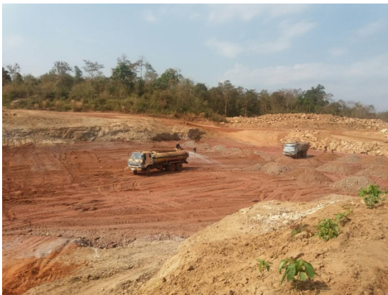
ภาพที่ 5.2.2-2 การขุดเปิดพื้นที่ส่วนใหญ่ให้แล้วเสร็จก่อนฤดูฝน
