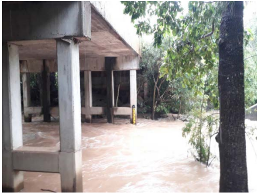
รูปที่ 7.3.2-6 การติดตั้งเสาวัดระดับน้ำ สถานี Kh.119 บ้านห้วยตาเปอะ อ.คำชะอี จ.มุกดาหาร
