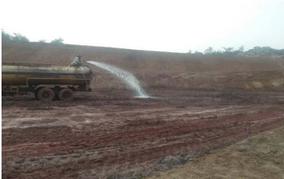
ภาพที่ 5.2.2-3 การฉีดพรมน้ำในพื้นที่ก่อสร้างเพื่อป้องกันฝุ่นละอองจากการก่อสร้าง
