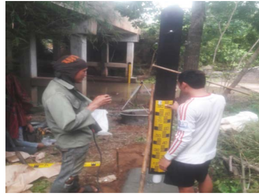
รูปที่ 7.3.2-6 การติดตั้งเสาวัดระดับน้ำ สถานี Kh.119 บ้านห้วยตาเปอะ อ.คำชะอี จ.มุกดาหาร
