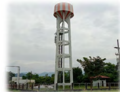
หอถังสูง ELEVATED TANK 50 \text{m}^3 H=25 m.
