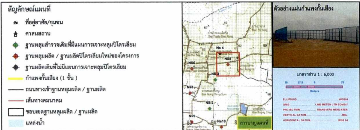
รูปที่ 2-1 ตำแหน่งติดตั้งกำแพงกันเสียง บริเวณฐานหนองสระ 5 (NS5) ในระยะก่อสร้างและติดตั้ง
