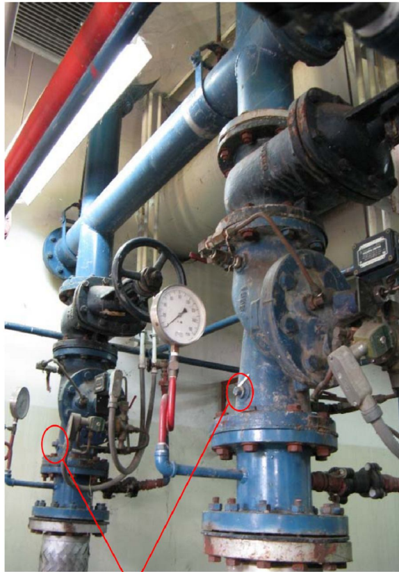
ตำแหน่งจุดเติมคลอรีนในเส้นท่อ
