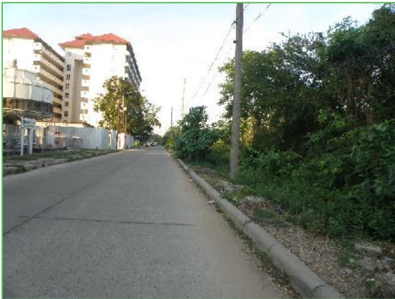
แนวท่อรวบรวมน้ำทิ้งจากระบบบำบัดน้ำเสียของ ลงบ่อเก็บน้ำตรงข้ามคณะแพทยศาสตร์
