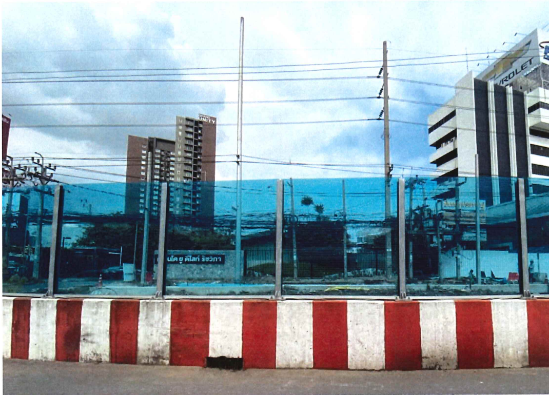
รูปที่ 4 ตัวอย่างความยาวที่เหมาะสมของกำแพงกันเสียง (Noise Barrier Design Handbook, FHWA)
