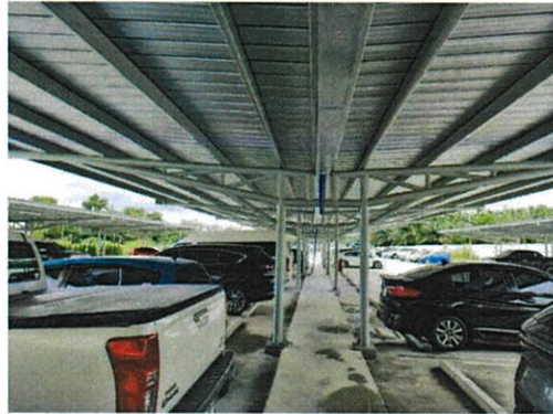
สภาพทางเดินเชื่อมจากที่จอดรถไปยังอาคาร
