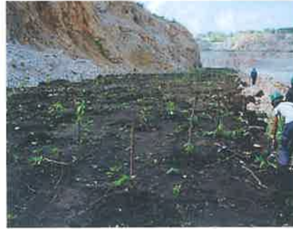
การนำดินคุณภาพต่ำบนหน้าเหมืองมาใช้ในการปรับถมฟื้นฟูสภาพเหมือง
