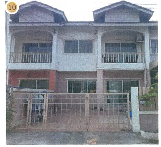
10. บ้านพักอาศัยสูง 2 ชั้น เลขที่ 325/9
