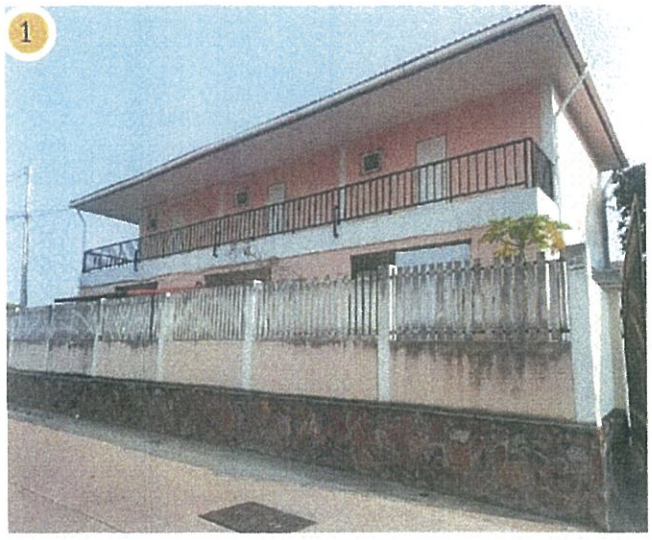
1. บ้านพักอาศัยสูง 2 ชั้น เลขที่ 166/36
