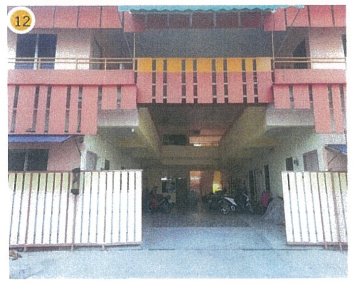
12. บ้านพักอาศัยสูง 2 ชั้น เลขที่ 325/14
