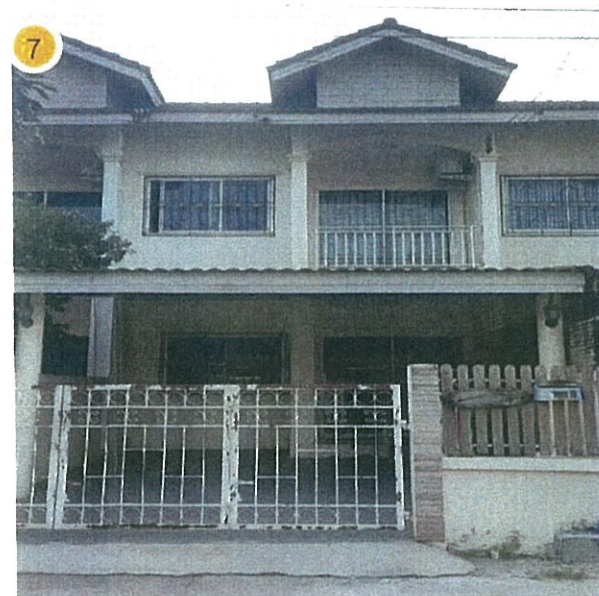
7. บ้านพักอาศัยสูง 2 ชั้น เลขที่ 325/6
