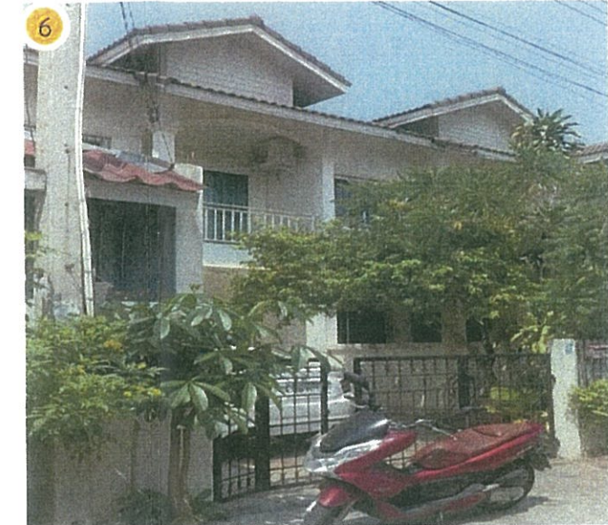
6. บ้านพักอาศัยสูง 2 ชั้น เลขที่ 325/5
