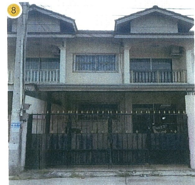
8. บ้านพักอาศัยสูง 2 ชั้น เลขที่ 325/7
