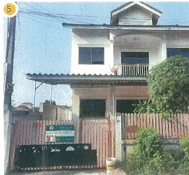
5. บ้านพักอาศัยสูง 2 ชั้น เลขที่ 325/2
